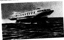
Рис. 184. Морской пассажирский теплоход на подводных крыльях «Вихрь». Скорость хода 38 узлов.
