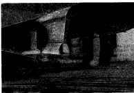
Рис. 122. Кормовое крыло и движительно-рулевой контур теплохода «Спутник».
